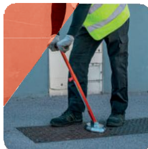
KROK 3 Pro uvolnění magnetu zatlačte rukojeť směrem k zarážce
